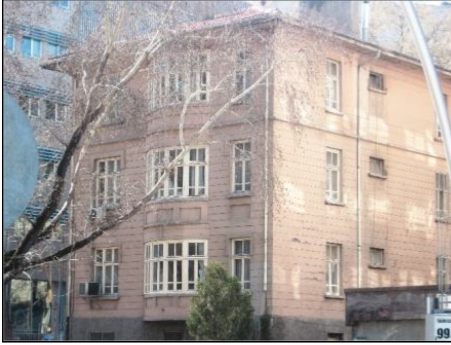
Binanın Giriş Yönünden Görünüşü
