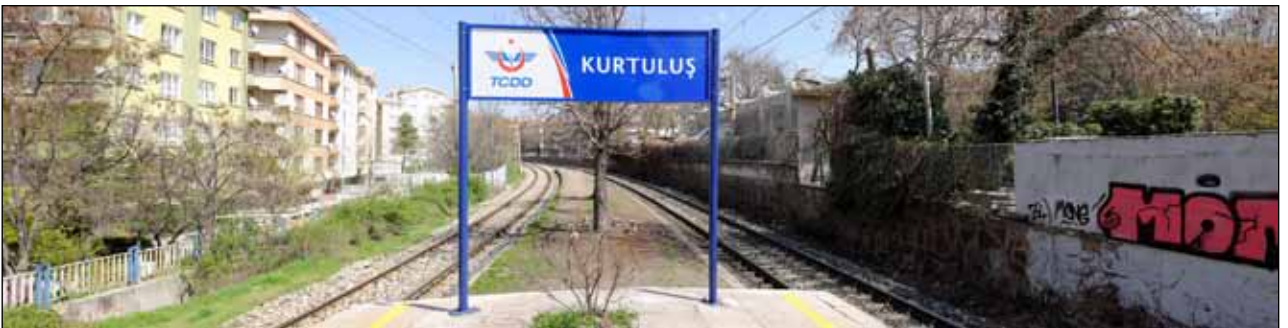
Şekil 23. Kurtuluş İstasyonu ve şehir merkezindeki konut - ticaret alanları.
